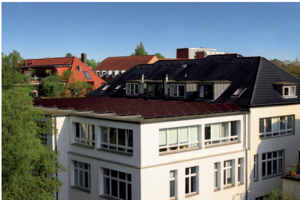
Minimale Ballastbeschwerung wird durch Modulreihenkopplung und Systemfixierung möglich
