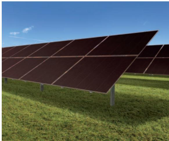
Freilandanlage mit amorphen Modulen auf Rammpfosten
