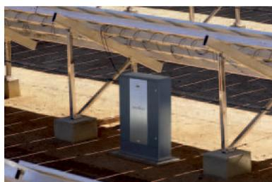
SGI 30k: der ideale Wechselrichter für Großanlagen
